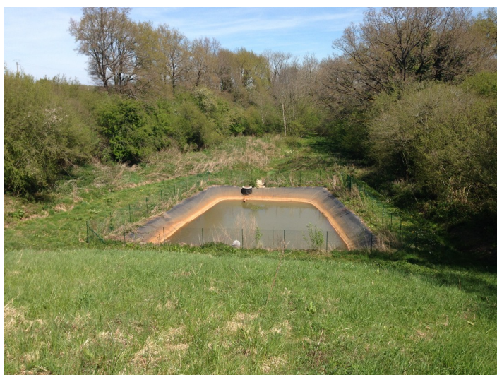
Vue sur le bassin de collecte et décantation des lixiviats
